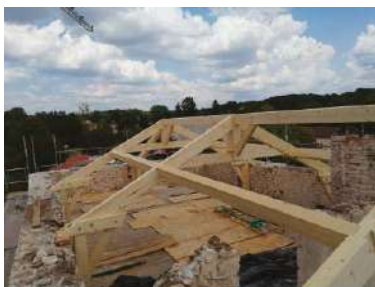
Remplacement à neuf de la charpente Fontanes (46) © EPF d'Occitanie
